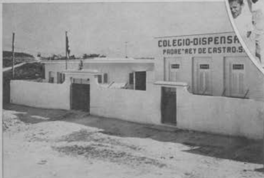
Una vista frontal del Colegio - Dispensario, que para los vecinos del barrio de las Yaguas ha levantado la Agrupación Católica Universitaria.
